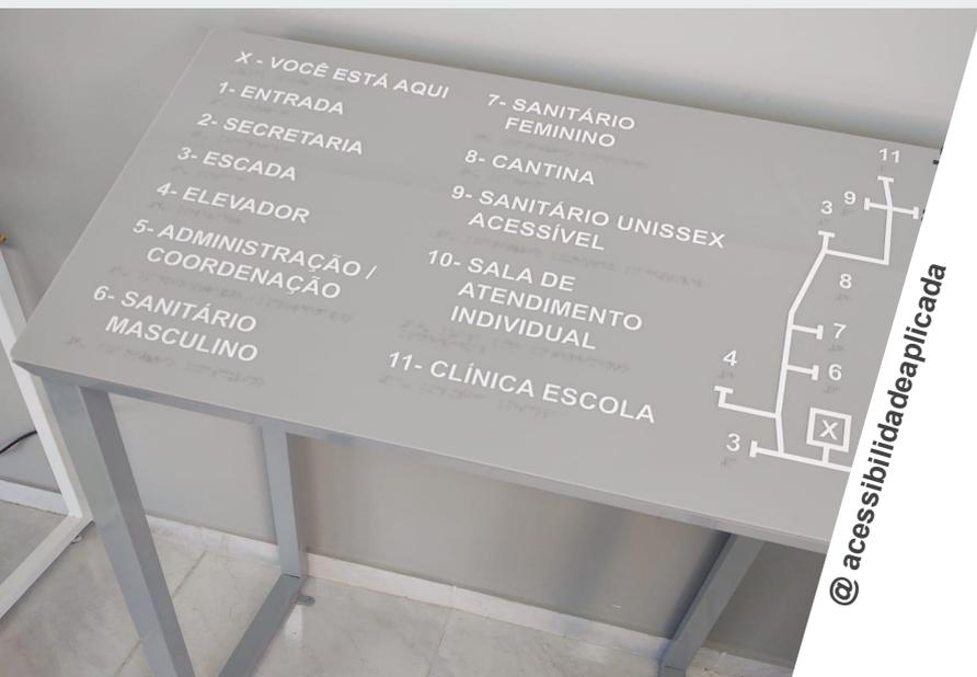
O Mapa Tátil é um novo tipo de elemento edificado a ser instalado nas edificações e que pode ser utilizado para indicar os ambientes existentes na edificação e garantir a autonomia para as Pessoas com deficiência visual ou baixa visão.
