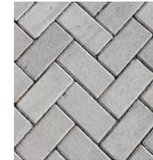
Piso intertravado de concreto na cor cinza.
